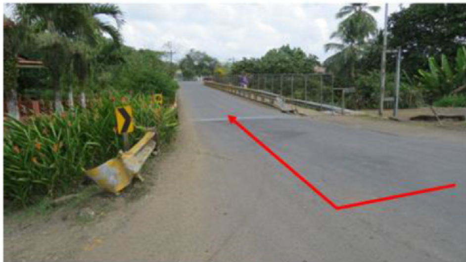
Puente sobre el Río San Rafael 14+340
