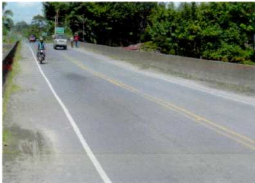
0+440 Puente sobre Río Chirripó
