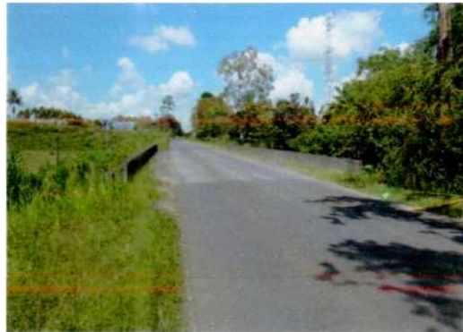
1+190 Puente sobre Brazo del Sucio
