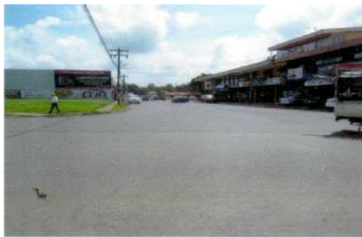
Estación 31+200 Cruce a Sarapiquí
