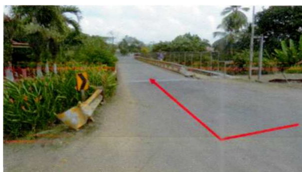
Puente sobre el Río San Rafael 14+340
