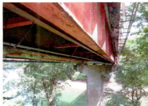
30+775 Puente sobre el Río Sarapiquí
